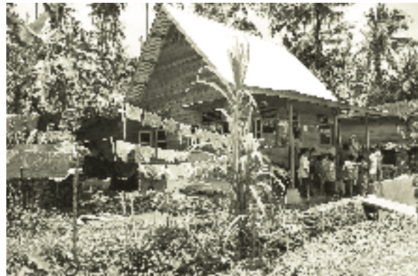
Eén van de vele nieuw gebouwde huizen.
