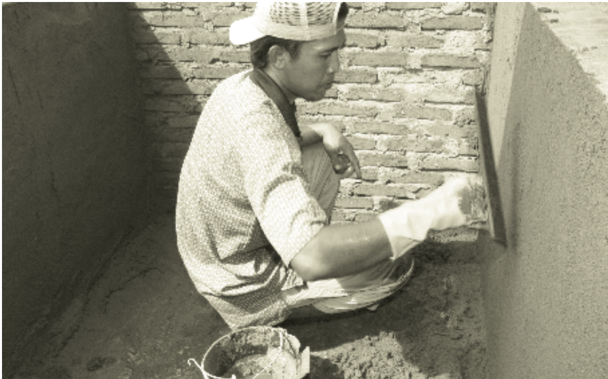
Een stukadoor werkt aan een nieuw huis.
